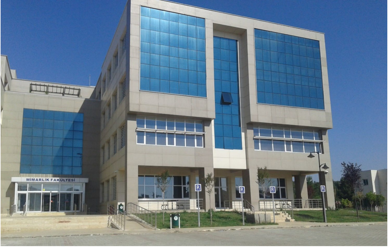
Şekil 1. Mimarlık Fakültesi Binası
