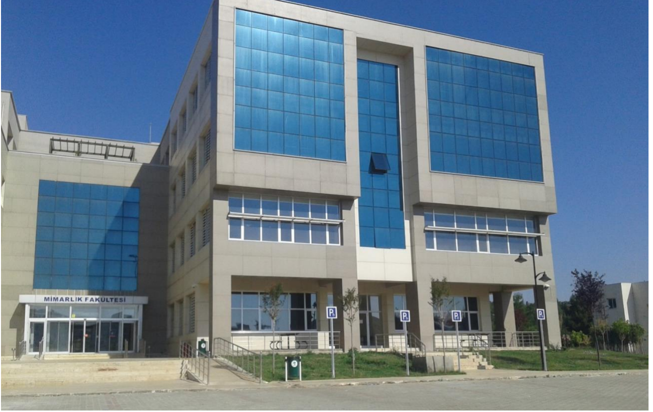
Şekil 1. Mimarlık Fakültesi Binası
