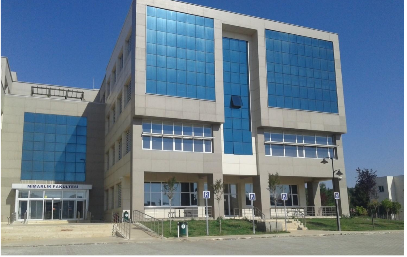
Şekil1. Mimarlık Fakültesi Binası
